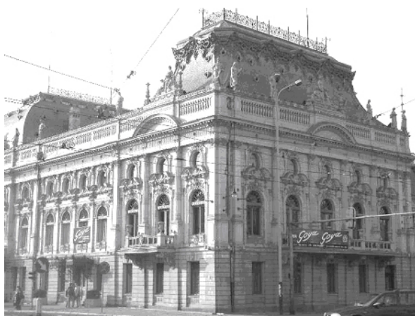
Ryc. 4 – Pałac I. K. Poznańskiego przy ul. Ogrodowej (fot. autor)
